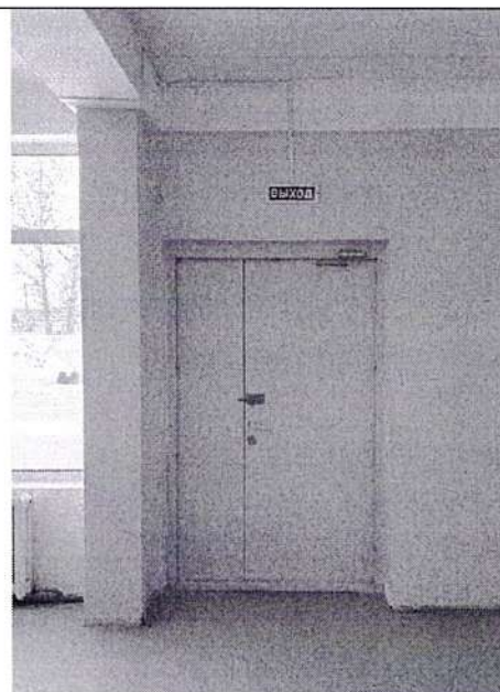
Эвакуационный выход левое крыло
