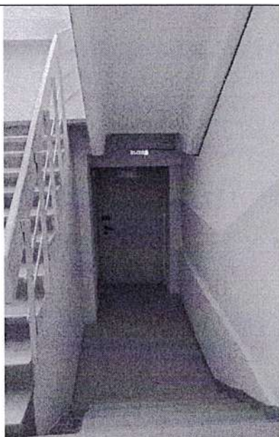
Эвакуационный выход правое крыло
